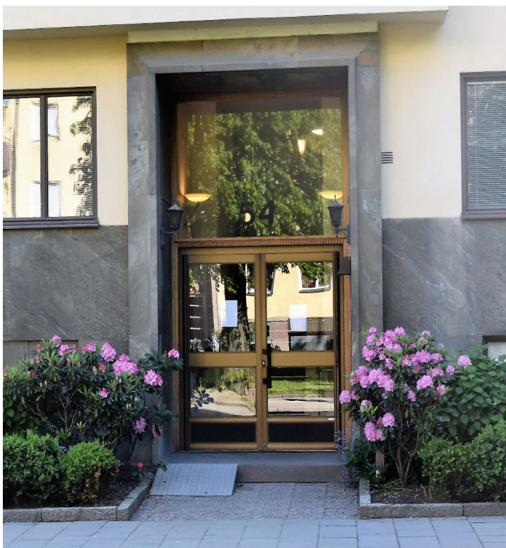
Figur 6. Detalj av huvudentré belägen mot Strindbergsgatan. Portomfattningen i ek är bevarad, men entrépartiet på senare tid utbytt mot eloxerad aluminium. Figur 7. ursprunglig entréport mot gården. Lägg märke till ursprungliga skärmtak.
