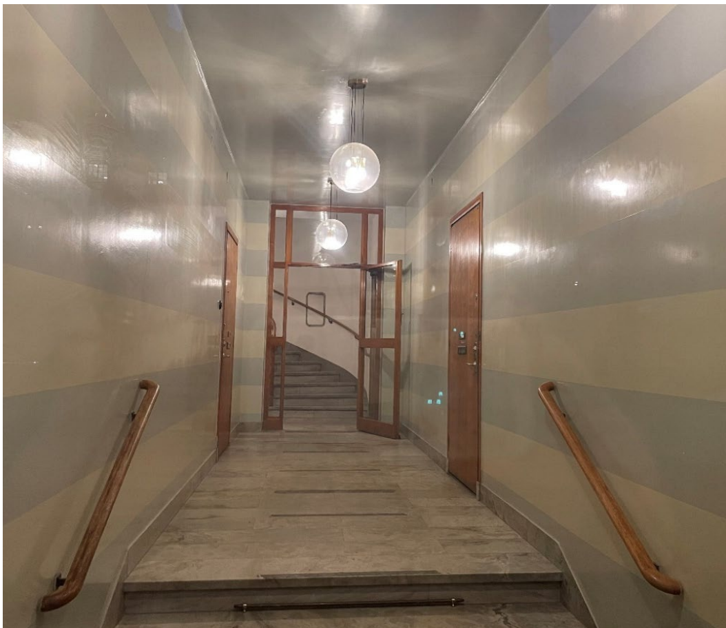
Lägg märke till att även taket i entrén är färgsatt. Den blank ytan är typisk för tiden. Se även de ursprungliga entredörrarna och belysningsarmatur.
