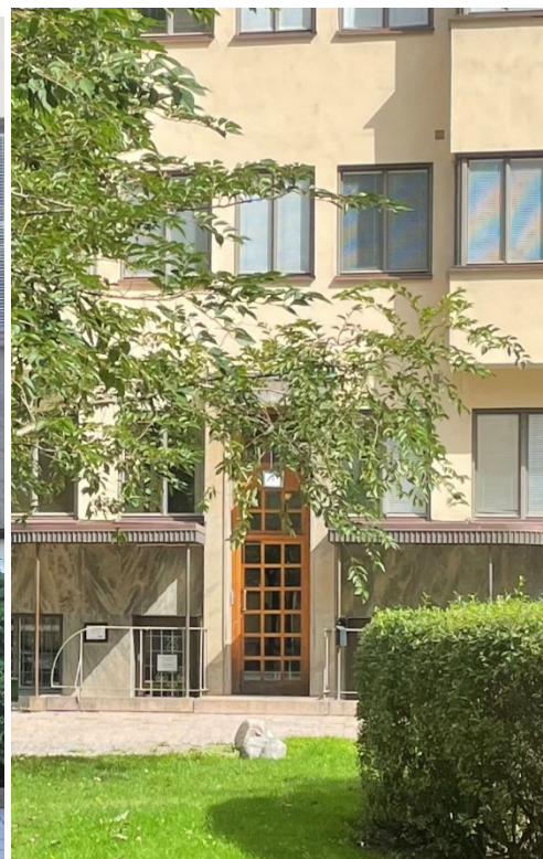
Figur 6. Detalj av huvudentré belägen mot Strindbergsgatan. Portomfattningen i ek är bevarad, men entrépartiet på senare tid utbytt mot eloxerad aluminium. Figur 7. ursprunglig entréport mot gården. Lägg märke till ursprungliga skärmtak.
