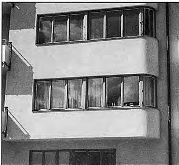
Fönsterparti i burspråk, rundat över hörn.
